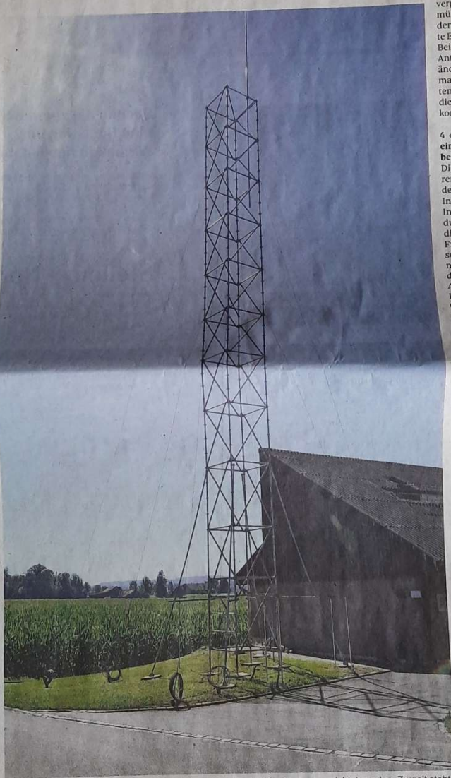
Auch bei der Kläranlage in Altikon im Thurtal soll eine 5G-Mobilfunkantenne errichtet werden. Zurzeit steht dort das Baugespann für die Antenne. Foto: Madeleine Schoder
